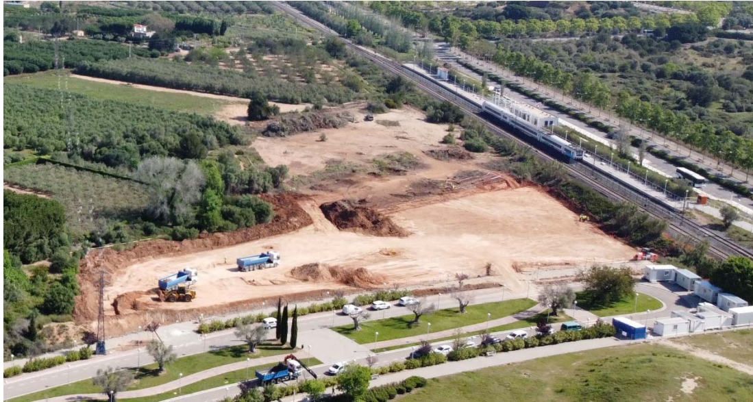
Estat actual i obres de construcció de l'estació de ferrocarril
